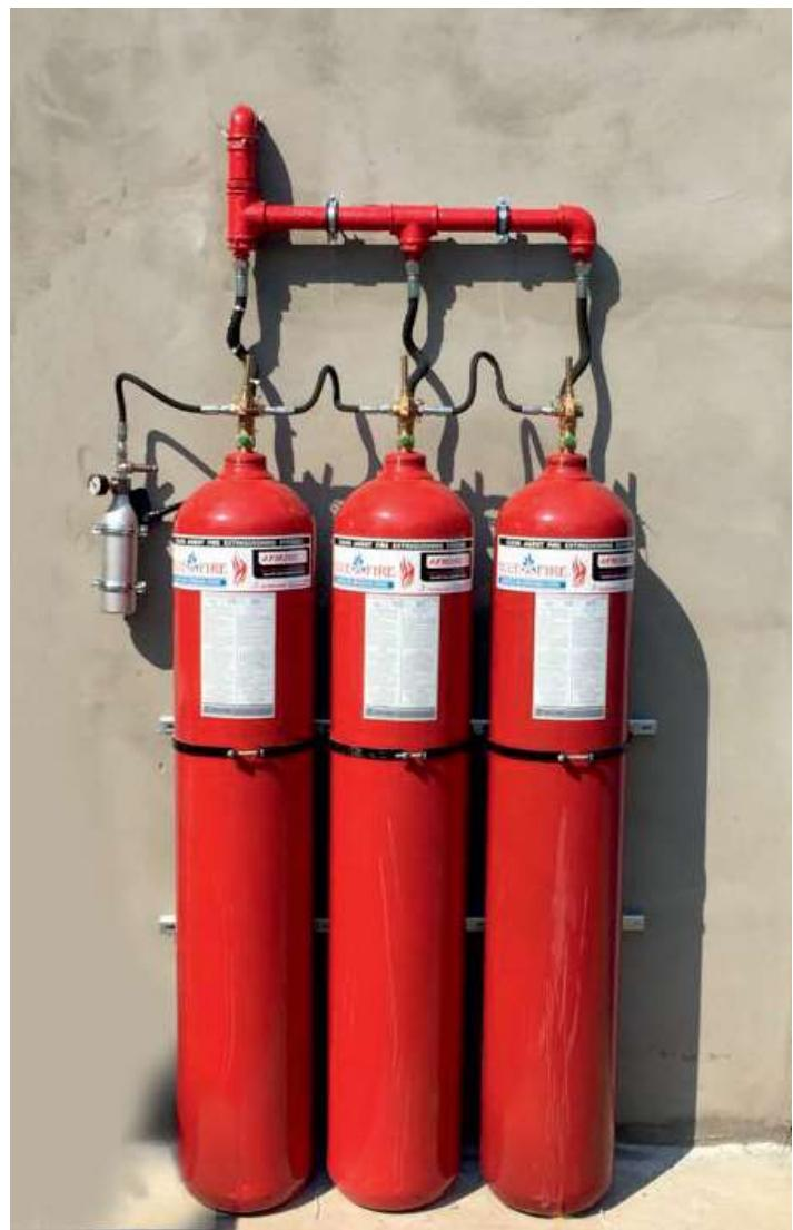
CO<sub>2</sub> gazı kendiliğinden yüksek basınçlı bir gazdır. Ortam sıcaklığına bağlı olarak gaz ve likit fazları arasında geçiş yapar. Bu yüzden manometre ile silindirlerin basınçlarını kontrol etmek mümkün değildir. Yangın alarm sisteminden silindirlerin durumunu kontrol etmek gereklidir. Ya da tartı mekanizması ile tüp ağırlıkları kontrol edilebilir.
